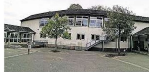
An der Angerhausen-Schule sollen Raumcontainer aufgestellt werden.
